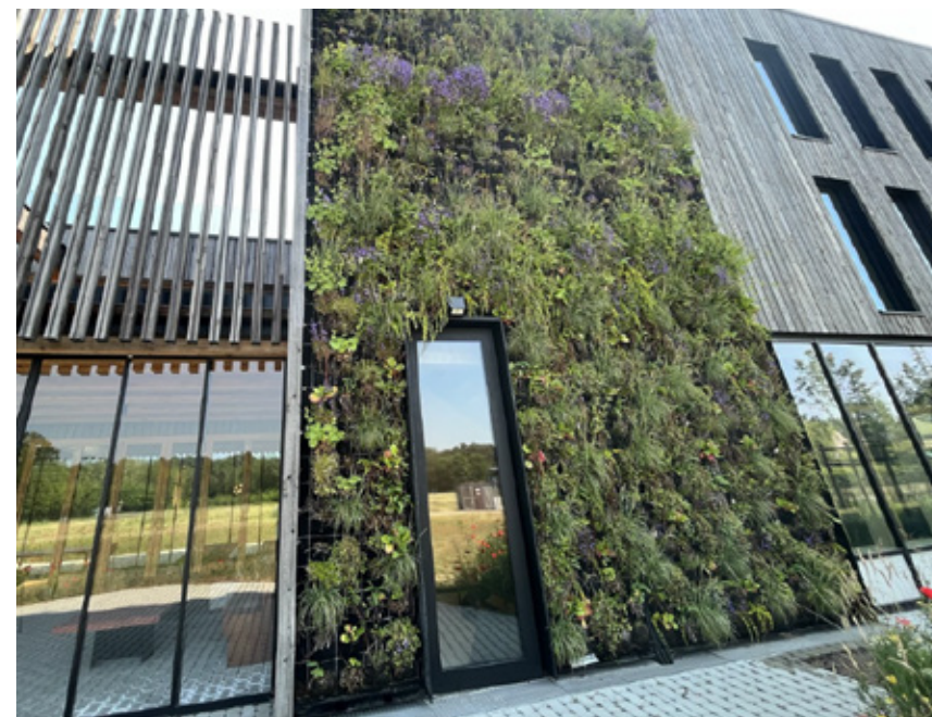
Figuur 13 Total Value Wall in kantoorgebouw, 't Centrum - Kamp C
