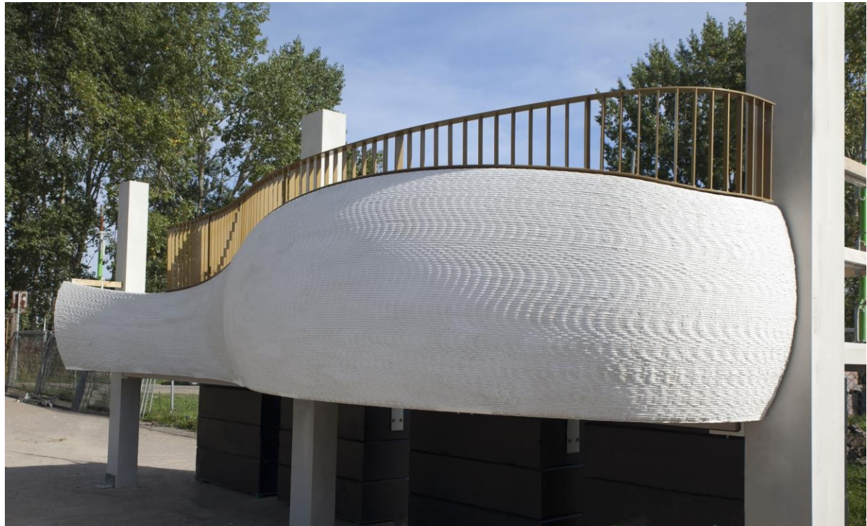
Bruil project Den Helder - gevel
